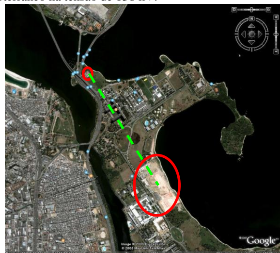
Fig.16 – Vista Aérea da Localização do Cenpes II e da Subestação de alimentação (distância 1,5 km)
